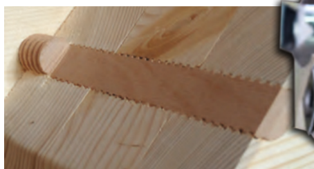
Всі збірні елементи виробляє Ромбач в Обергармербахсі (Баден-Вюртемберг) з твердої деревини з допомогою різьбових стрижнів з бука без клею. Конструкція запатентована і дозволяє отримати жорсткі компоненти абсолютно без клею.
